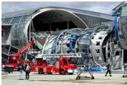
Roissy Terminal 2E roof collapse
